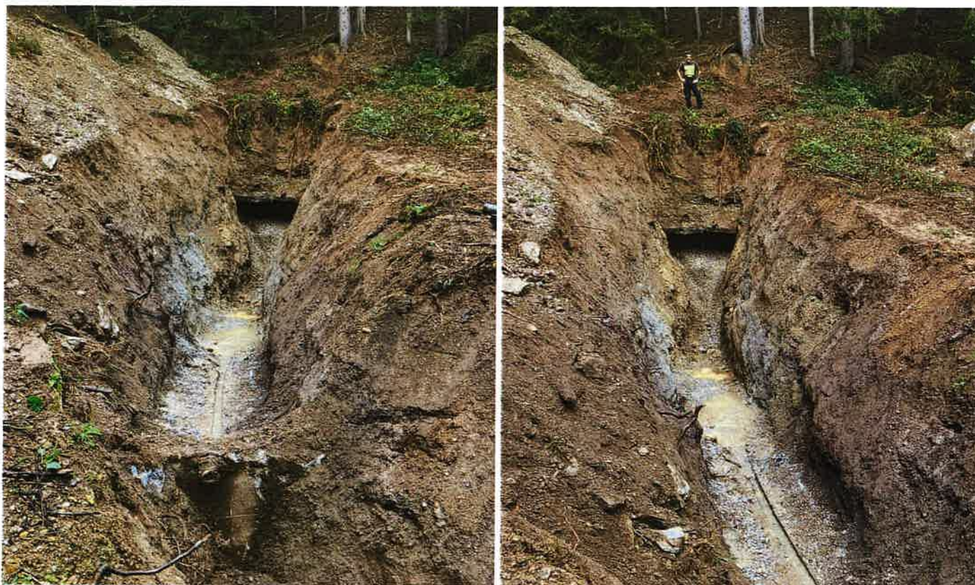
Sanierung der Quellfassung bei der Zigeunergrabenquelle
